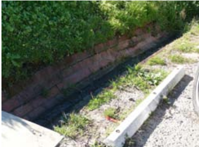
Brick drainage gutter (H.12)
